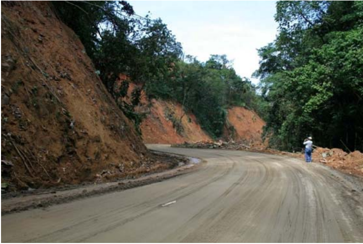
Steep Slopes on Barre de L'Isle Roadway
